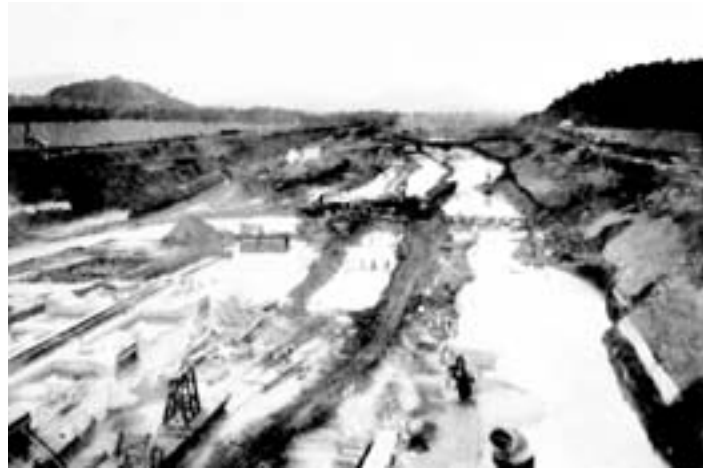
Imagen No. 1: Obras de construcción del Canal
